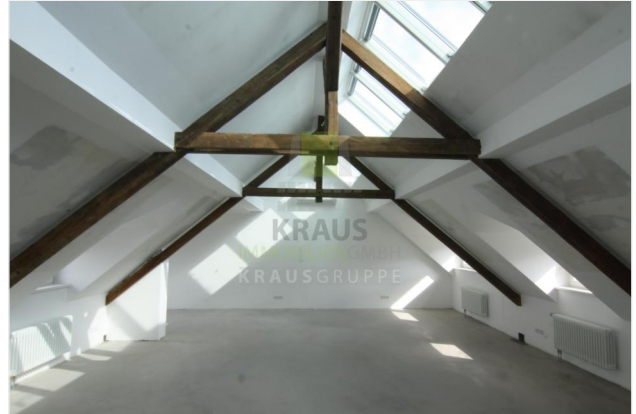
Impressionen - Ausbaustand Oktober 2022
