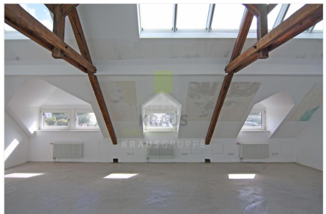
Impressionen - Ausbaustand Oktober 2022
